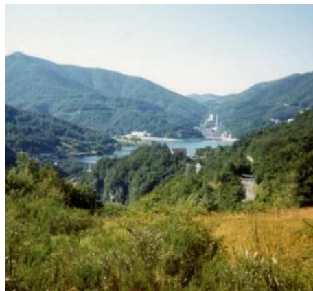
Bacino artificiale del Brasimone. La diga venne inaugurata nel luglio 1911 e la sua capacità utile è di circa 6.6 milioni di metri cubi. Sullo sfondo il Centro Ricerche ENEA del Brasimone.
